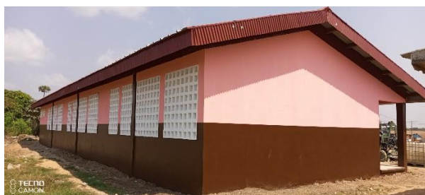
Photo 2 : Perspective cavalière montrant la façade arrière et la façade latérale droite
