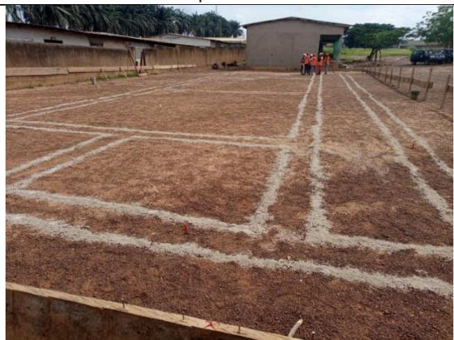
Photo 3 : Matérialisation au sol des limites de fouilles
