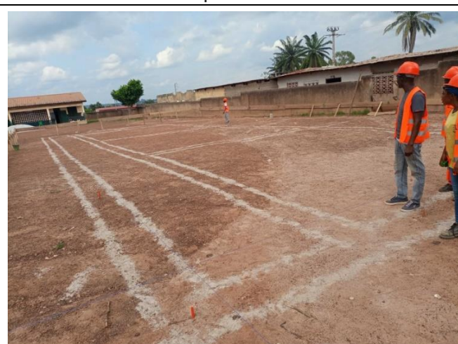
Photo 4 : Matérialisation au sol des limites de fouilles
