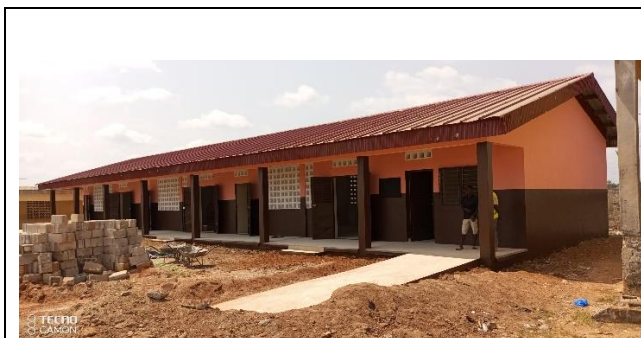
Photo 1 : Perspective cavalière montrant la façade principale et la façade latérale gauche
