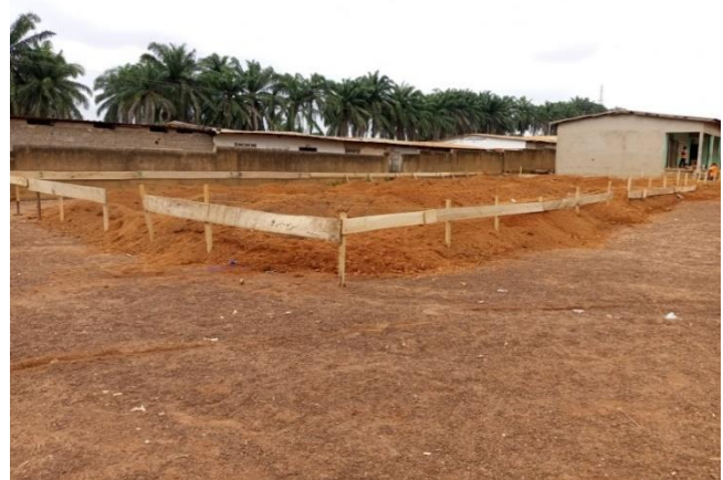
Photo 5 : Fouilles en rigole en cours
