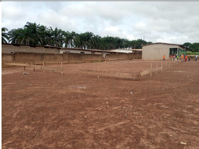
Photo 1 : Implantation en cours
