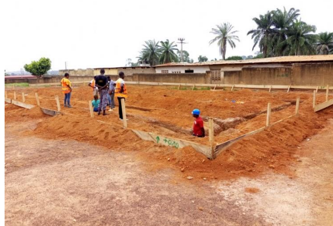
Photo 6 : Fouilles en rigole en cours
