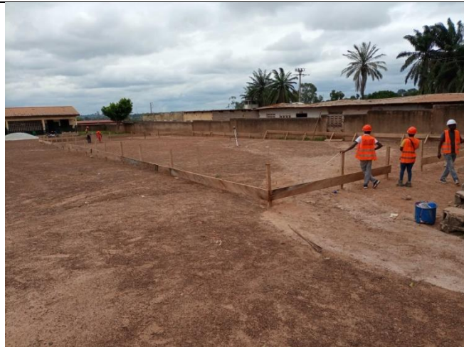
Photo 2 : Implantation en cours
